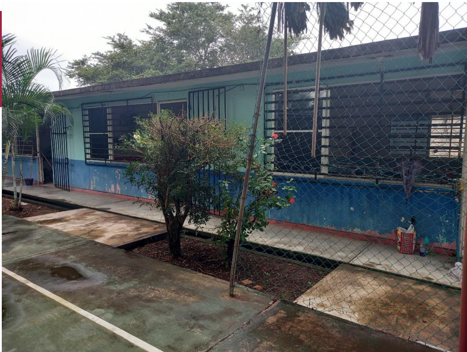
Instalaciones de la Telesecundaria “Carlos A. Carrillo”
